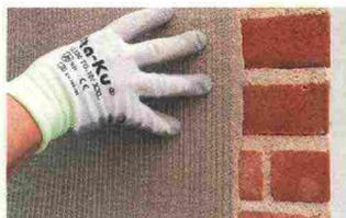
Malta di consolidamento a base di calce idraulica naturale, ideale per
