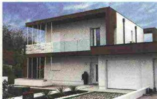
Con la definizione di "isolamento termico a cappotto esterno" spesso identificato con l'acronimo ETICS - *External Thermal Insulation Composite Systems* - s'intende il rivestimento esterno delle pareti di un edificio tramite pannelli isolanti di varia natura che, grazie alla loro bassa conducibilità termica riducono drasticamente il passaggio di calore tra
